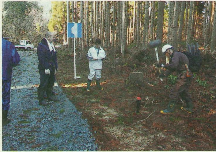
境界に杭を打つ作業の様子。明確化が地道に進められている
